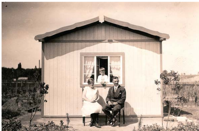
Kleingärtnerstolz anno 1932: Das Ehepaar Heise mit Sohn Lothar an der gerade errichteten Gartenlaube.
